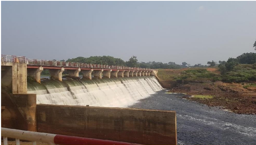
Figure 2 - Évacuateur de crue – Barrage de Mekin – 29 janvier 2020 (Source : M. Niassa)
