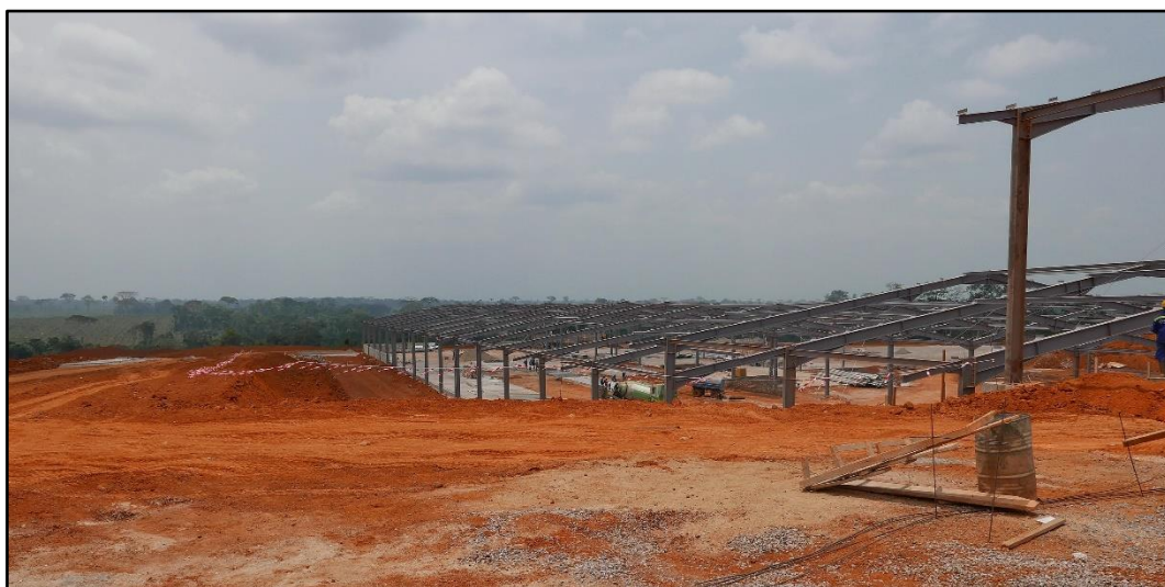
Figure 8. Chantier de construction de la nouvelle usine
