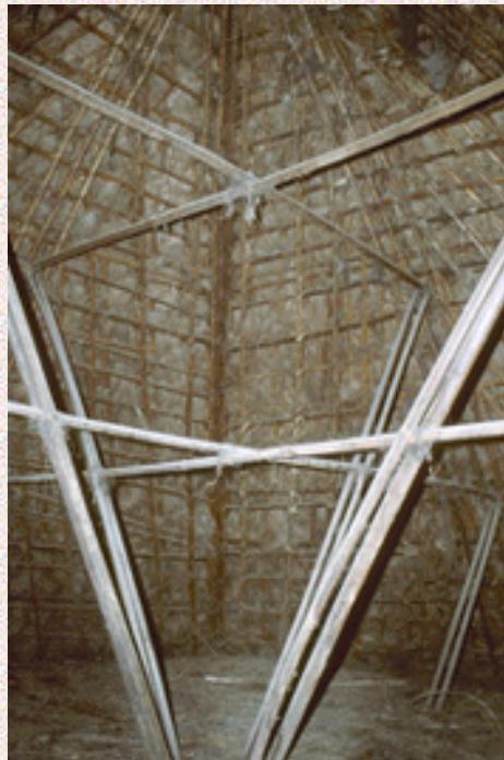
**Construction des toits à double couverture;**
