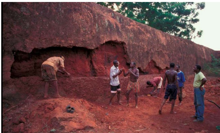
Travaux de consolidation d'un mur d'enceinte, 1998
