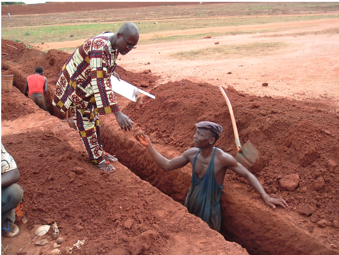
Découverte d'artefacts durant les travaux d'enfouissement des réseaux électriques sur la Place Singbodji
