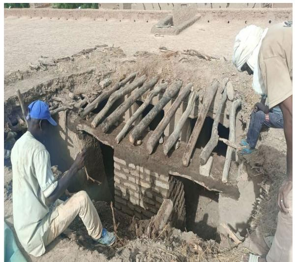
*Travaux de réparation de pilier et de la toiture effondrée par la pluie*
