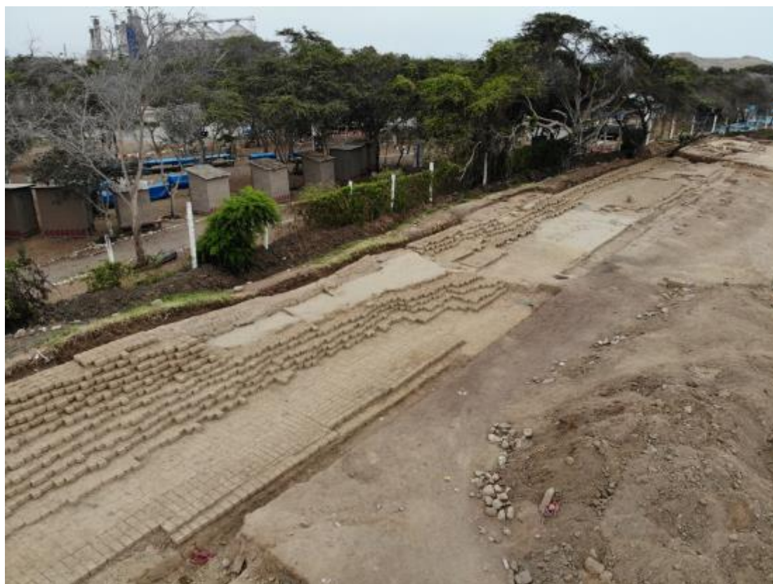
Reestructuración con adobes modernos de una sección del muro perimetral este (parte sureste) afectado por el canal de regadío.
