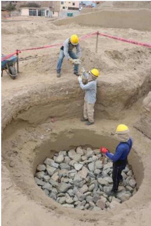
Implementación de sistema de drenaje. Acondicionamiento de pozo percolador y zanja de drenaje.
