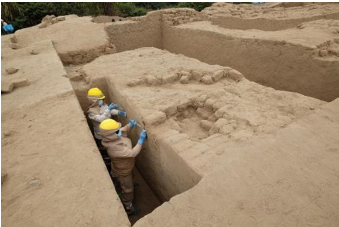
Tratamiento de enlucidos. Limpieza y consolidación de enlucidos.
