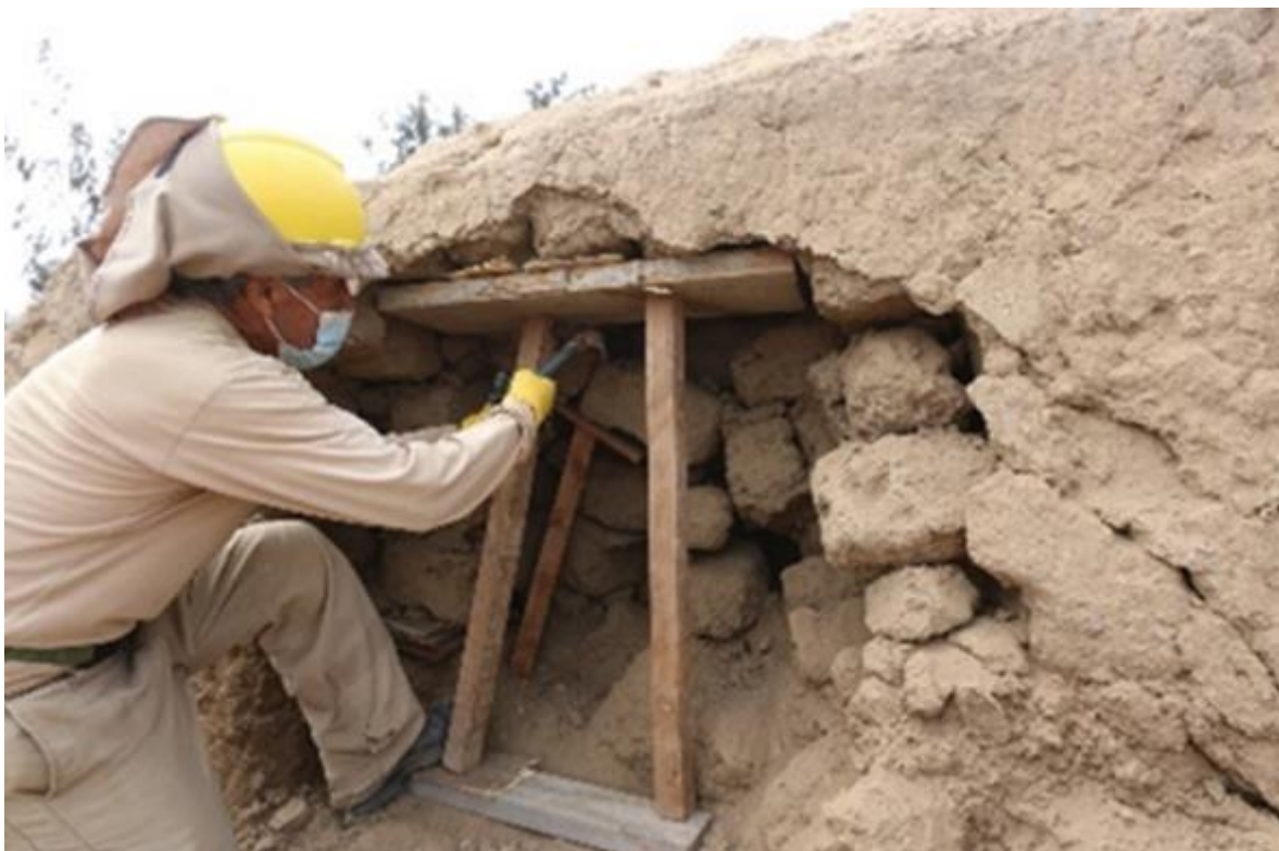
Apuntalamiento preventivo en una sección del muro perimetral este.
