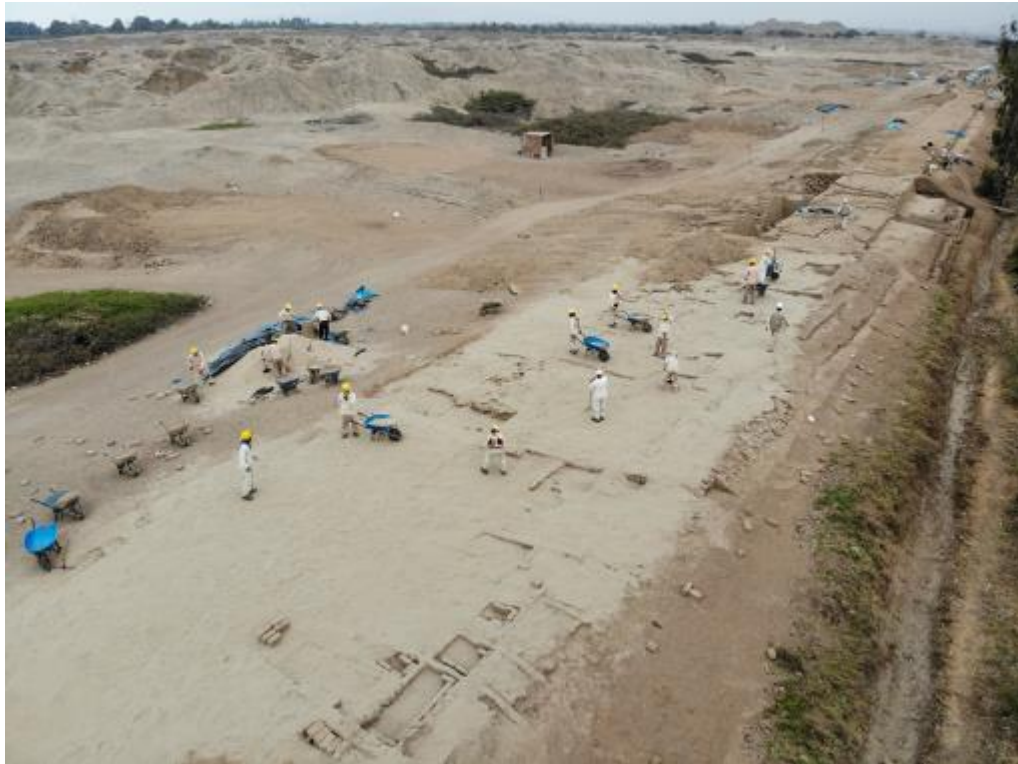
Protección de la arquitectura tardía registrada sobre el muro perimetral este en una de sus secciones.
