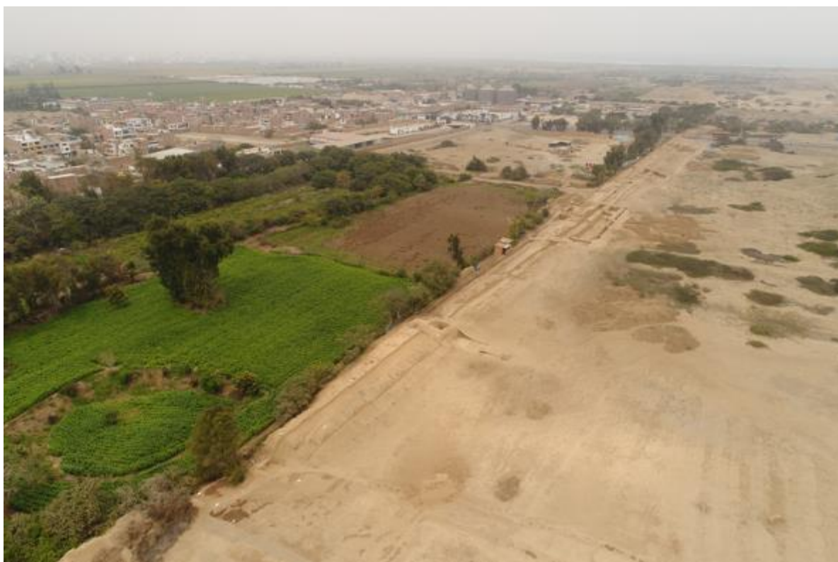
Vista panorámica de las unidades de excavación en el muro perimetral este.
