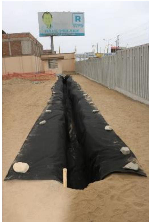
Implementación de sistema de drenaje. Acondicionamiento de pozo percolador y zanja de drenaje.
