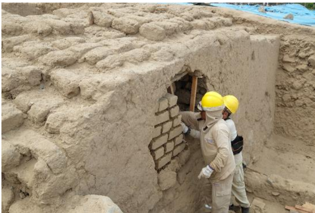
Calzadura preventiva en uno de los elementos arquitectónicos asociados al muro perimetral este registrado en la unidad 09.
