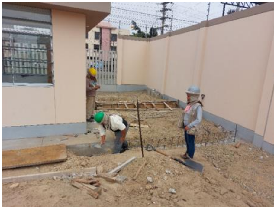
Acompañamiento arqueológico de actividad de encofrado para sardineles-acondicionamiento de senderos
