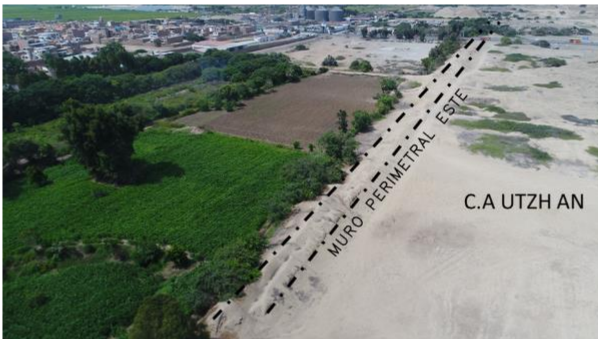
Vista panorámica del muro perimetral este antes de su intervención - Temporada 2024.
