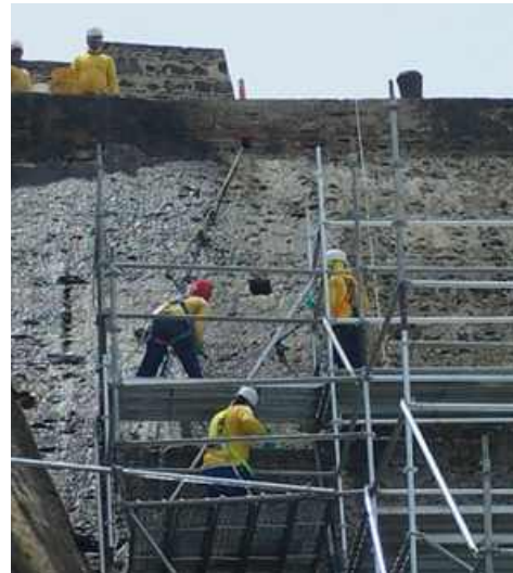
Limpieza y retiro de costra negra
