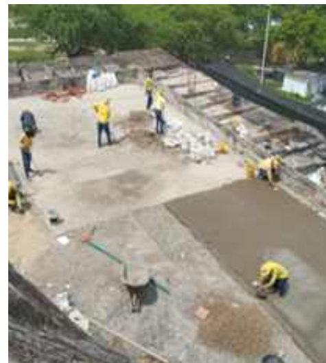
Refacción de solados
