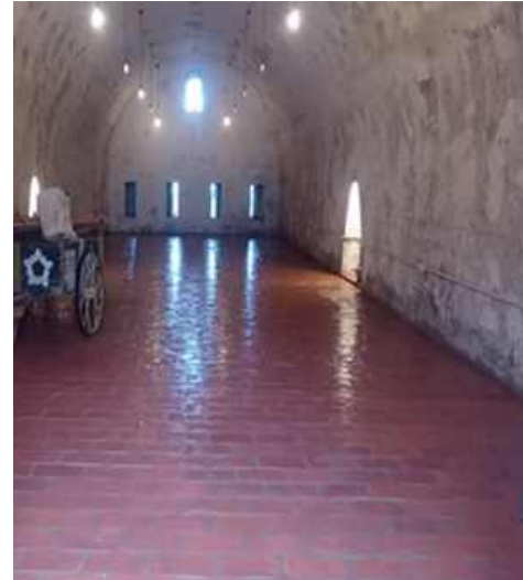
Adecuación Bóveda No. 5 del Cuartel Militar de las Bóveda
