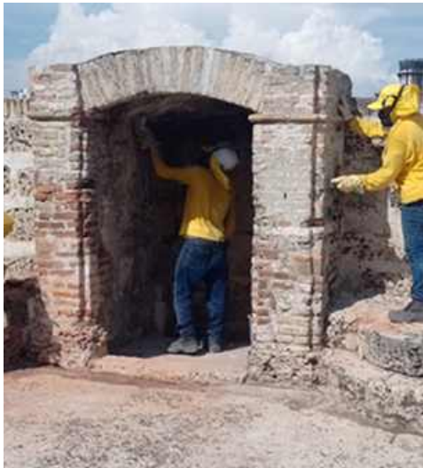
Consolidación de jamba
