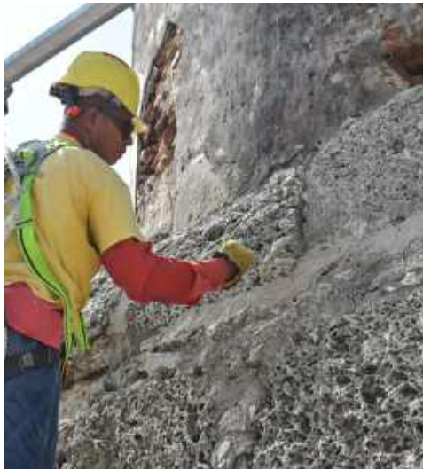
Limpieza y consolidación de juntas en escarpas
