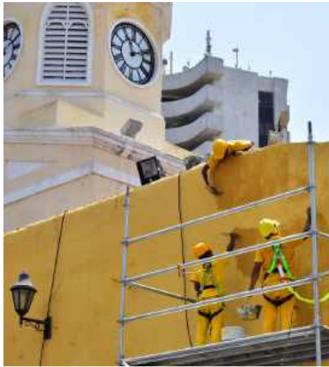
Mantenimiento de superficies pañetadas
