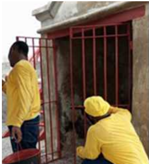
Mantenimiento preventivo y correctivo elementos metálicos
