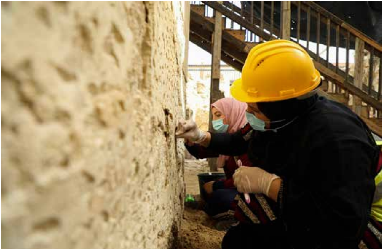
Fig 14: Plaster preservation (PUI)
