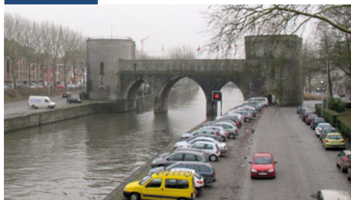
Phase 4 Vue d'ensemble
