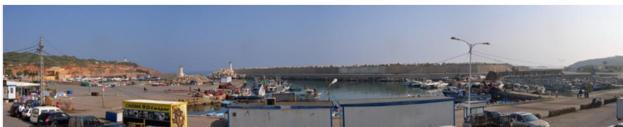
2. Vue panoramique du port de Tipasa
