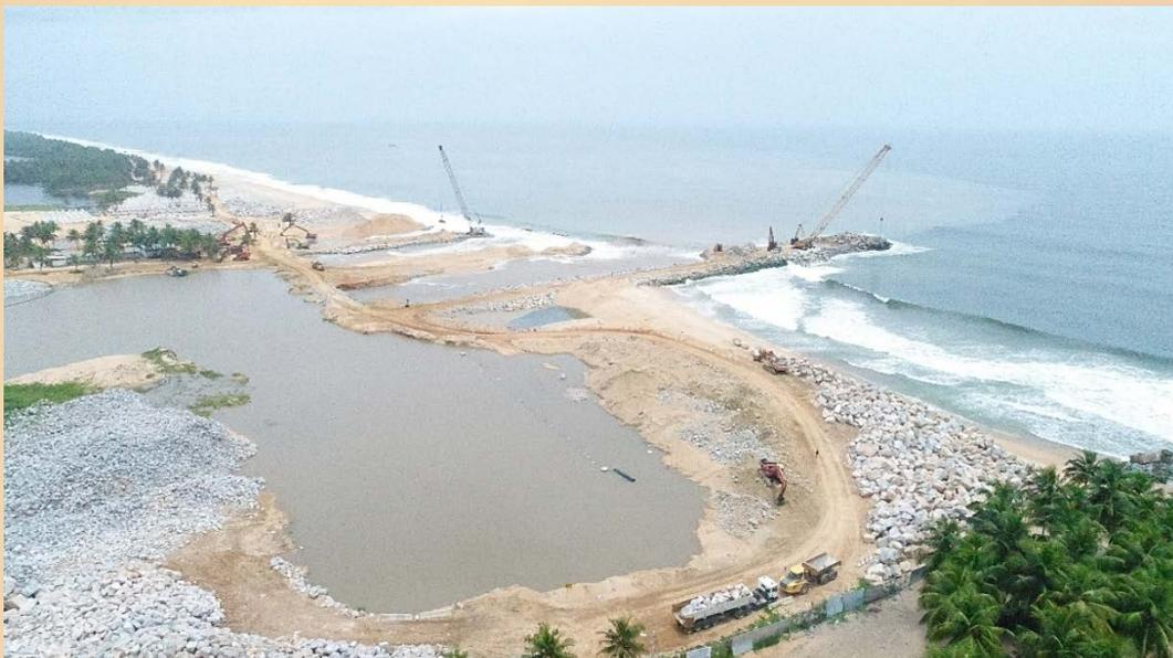
**Photo 7** : Un aperçu de l'état d'avancement des travaux de réouverture de l'embouchure (un taux d'exécution de 67%) (Source : Archives SE-VHGB, 2022).
