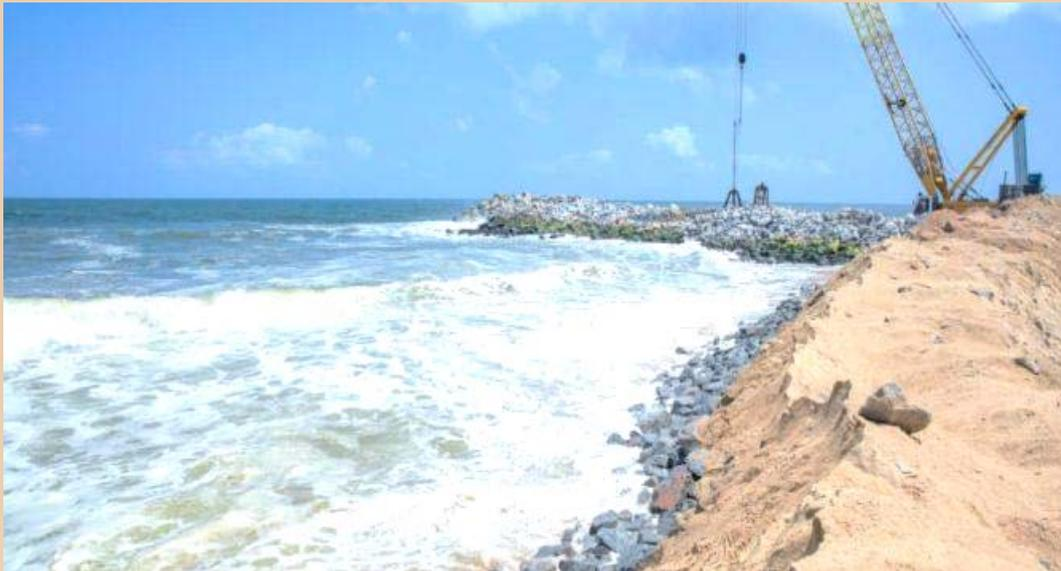
**Photo 6** : Construction des épis (digues) relatifs aux travaux de réouverture de l'embouchure de Grand-Bassam en cours (Source : Archives SE-VHGB, 2022).
