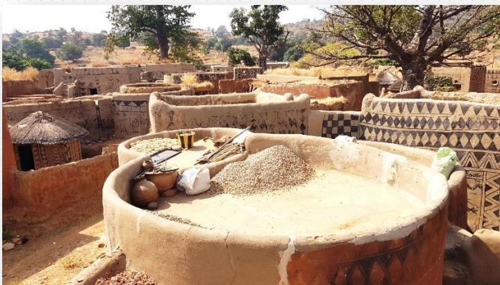
La toiture-terrace en terre repose sur une structure désolidarisée du mur, constituée de poteaux en bois en forme de fourche assemblés avec des poutres et des poutrelles en bois. Les poutres reposent en partie sur les murs. On note cependant une évolution récente des techniques architecturales, la toiture repose directement sur les murs.
