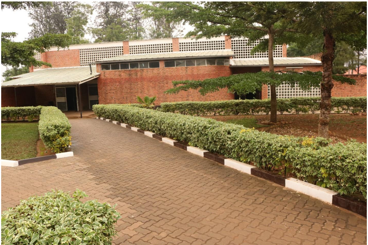
Photo 1. Site de Nyamata vue de face
