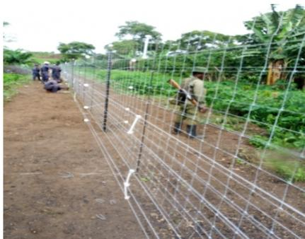
Figure 4 : Démarcation type avec la clôture électrique
