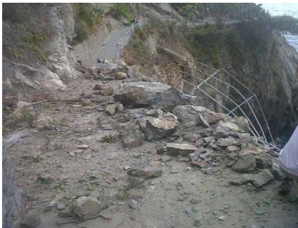
Figura 18. Frana sulla Via dell'Amore
