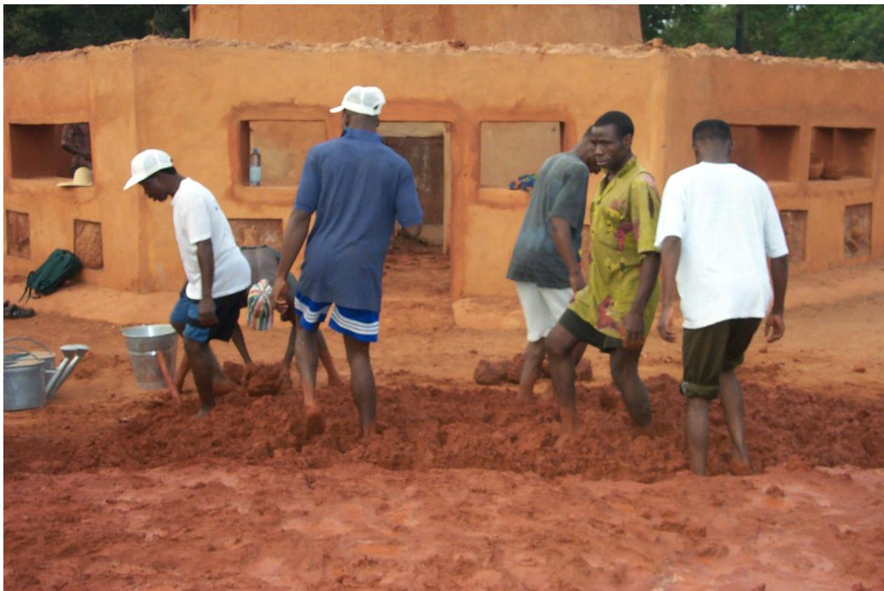
Photo 10 : Travail de la terre préalable au montage des murs
