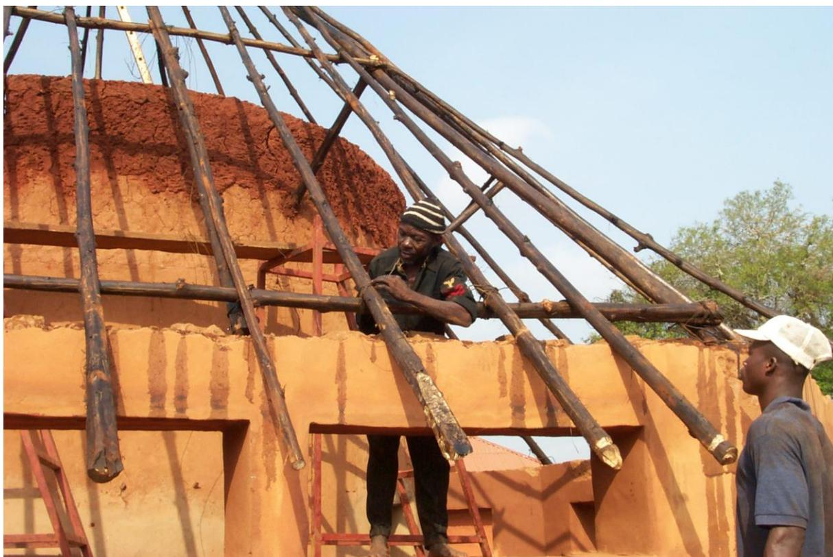
Photo 15: Construction traditionnelle de la toiture d'un Jèho
