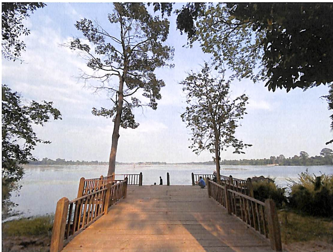
TEMPLE DE PREAH KHAN : RÉHABILITATION DE L'EMBARCADÈRE (DU CÔTÉ DU BARAY NORD)
