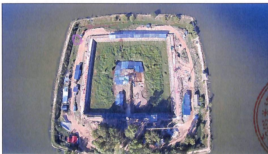
CONSOLIDATION ET RESTAURATION DU TEMPLE DU MEBON OCCIDENTAL (FRANCE-APSARA)
