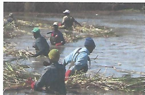
**Photo 2** : Nettoyage Typha par manœuvre
