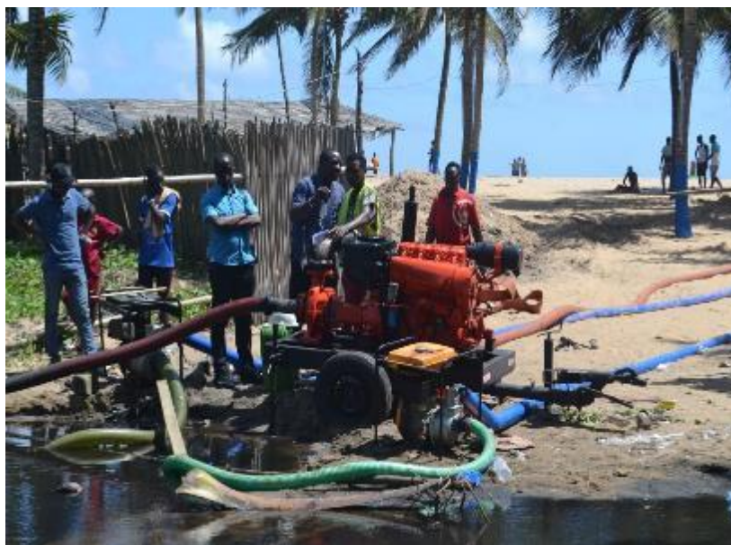
Image 4 : Une vue des motopompes convoyées sur le site pour essayer de juguler l'inondation
