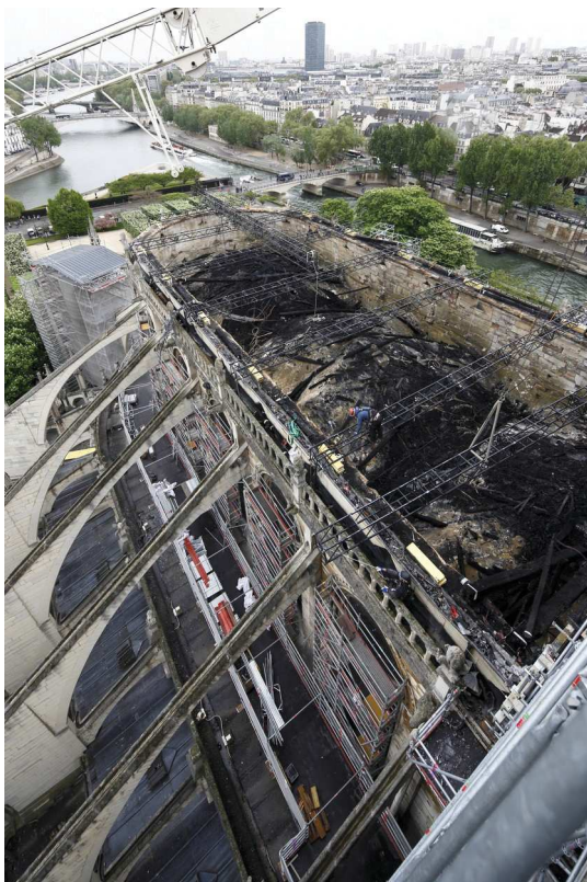
Mise en place des poutrelles métalliques © ministère de la culture David Bordes
