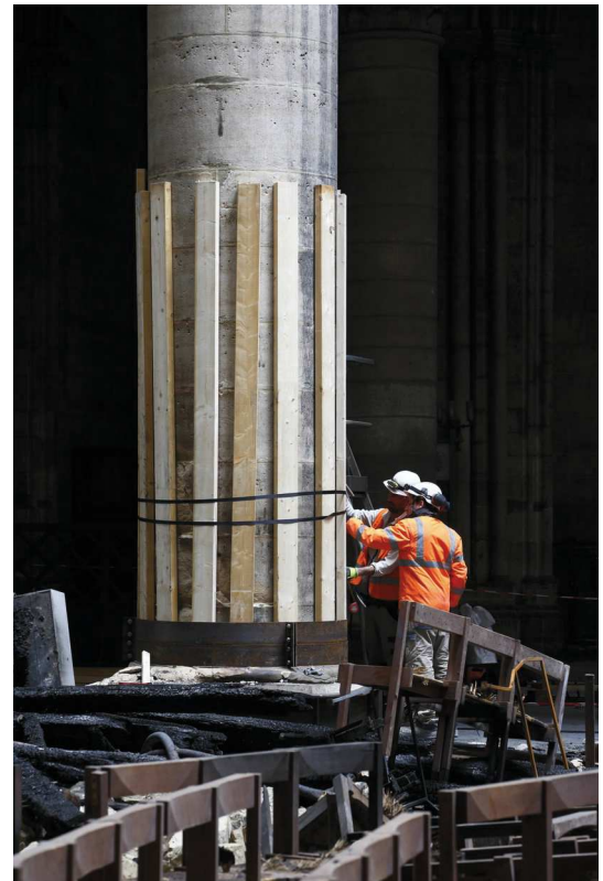
Frettage d'une pile de la nef © ministère de la culture David Bordes
