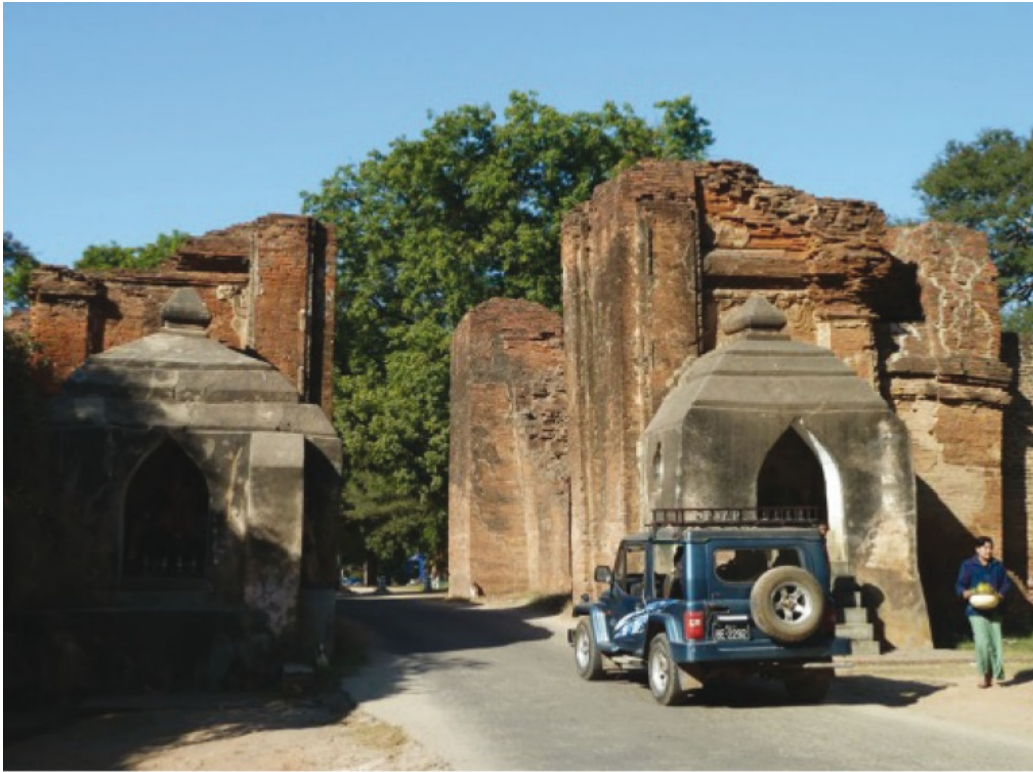
Mur d'enceinte d'Old Bagan et la porte de Tharaba
