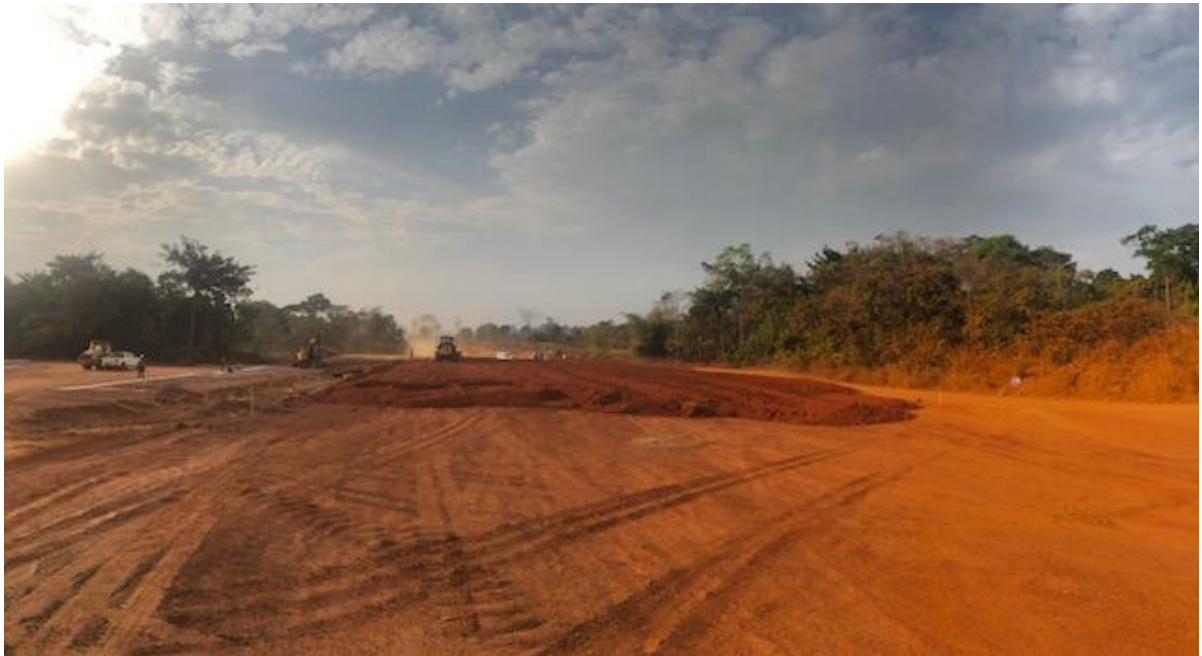
Photo 2. Travaux d'élargissement de la route Lola-Danané
