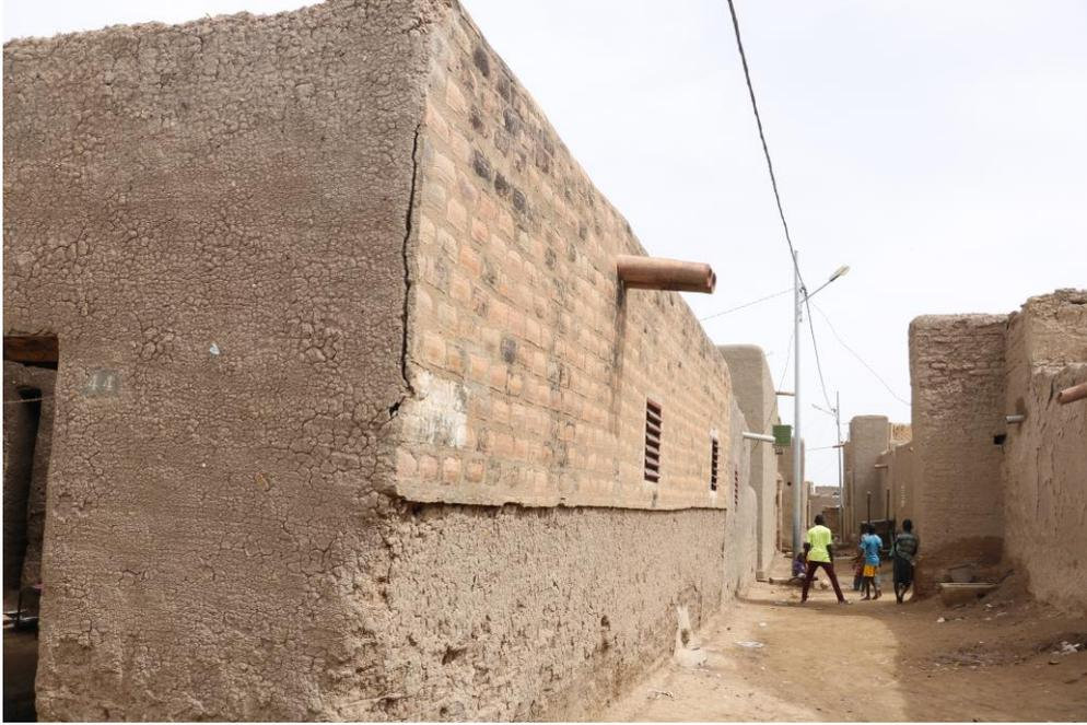
*Figure 14: Maison en terre partiellement endommagée par le revêtement en briques cuites (sept.2017)*
