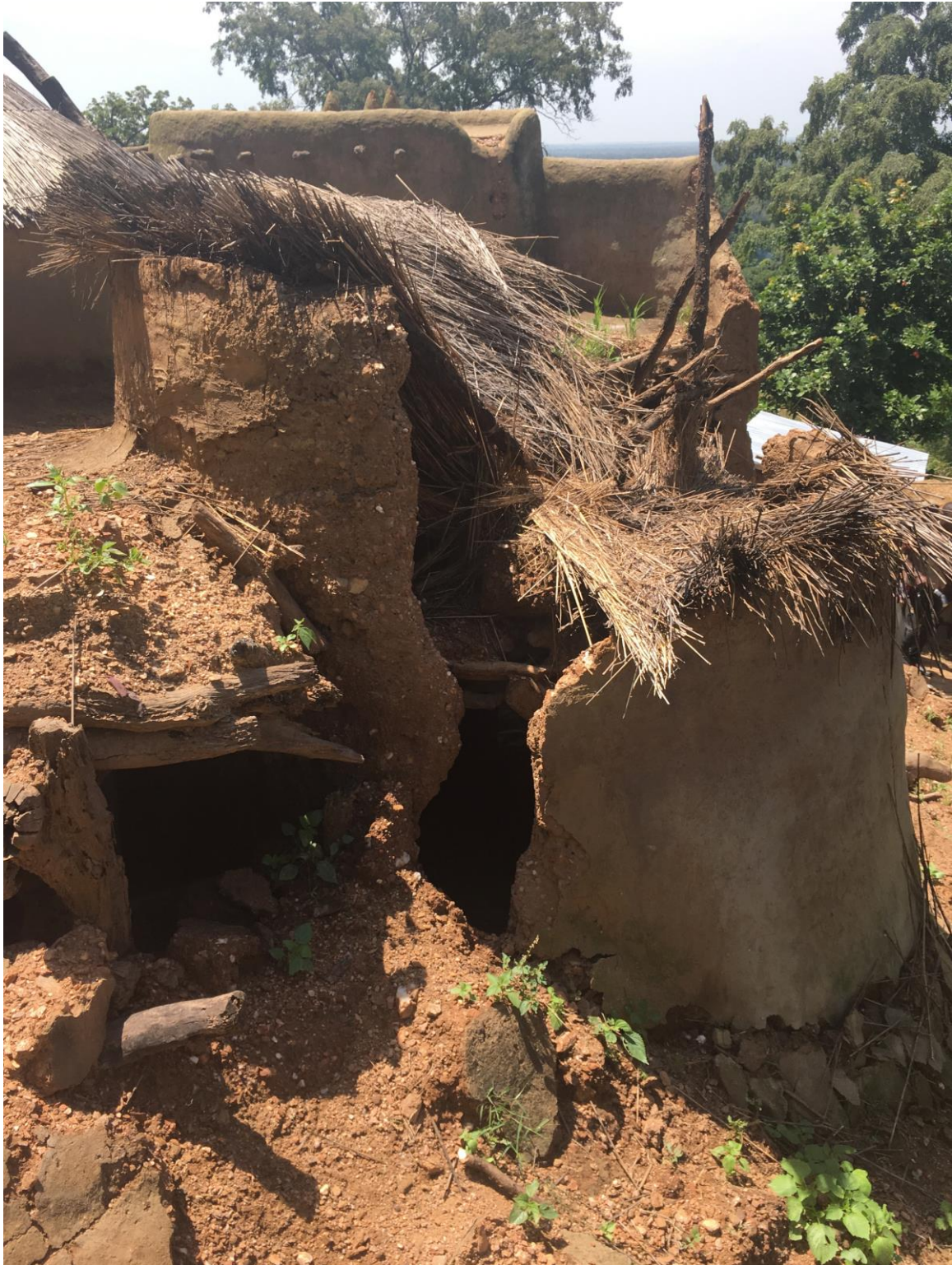
Enduit de ciment sur un mur de takienta qui se trouve au bas de colline à Bassamba, octobre 2018 ©UNESCO/Ishanlosen Odiaua
