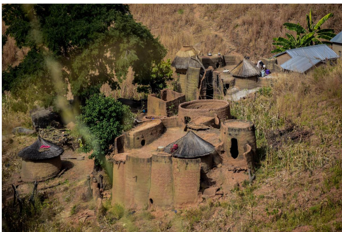
Vu d'un ensemble démontrant une takienta partiellement effondrée, novembre 2018
