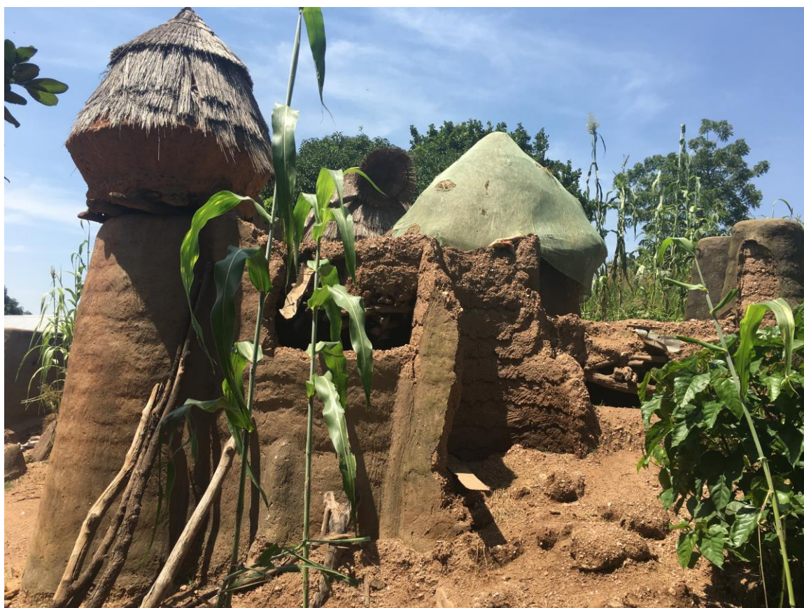
Takienta partiellement effondrée à Bassamba, octobre 2018 ©UNESCO/Ishanlosen Odiaua
