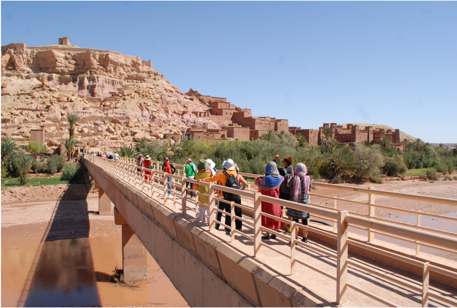
Vue du pont
