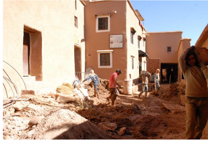
Exemples de restauration de la kasbah du cheikh avec le chantier de préparation de la terre
