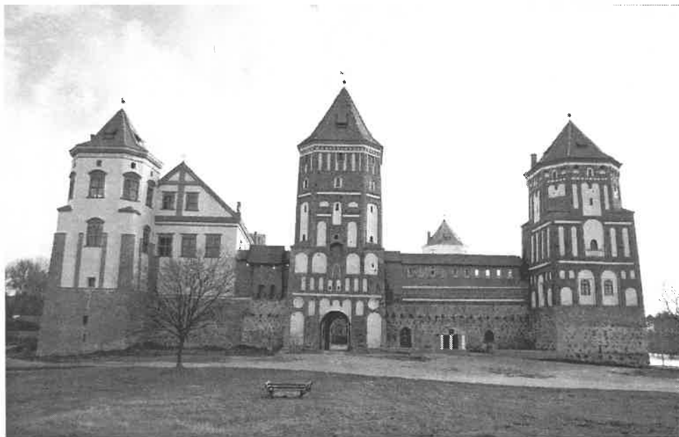
Façade ouest et tour d'entrée / Western facade and gate tower
