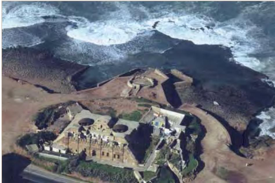
Il confia alors, les travaux à l'ingénieur allemand Walter Rothenburg. Le fort a la forme d'un rectangle. Il est entièrement construit en béton et en maçonnerie. L'entrée était constituée par une galerie souterraine avec une porte et un pont levés. Elle communiquait jadis avec les casemates qui servaient de logements à la garnison et de dépôts de munitions et d'approvisionnement. Le fort était équipé d'une batterie de canons modernes.
