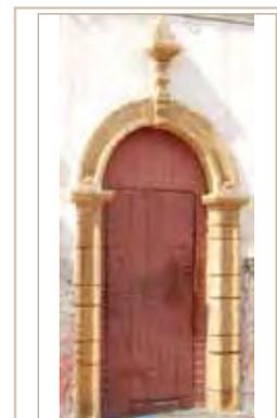
Type 2 : Arc plein cintre coiffé d'un modillon et dépourvu d'encadrement.
