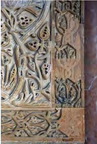
Intervenciones alternativas ensayadas en la historia de recomposición del ataurique en el Salón Rico
