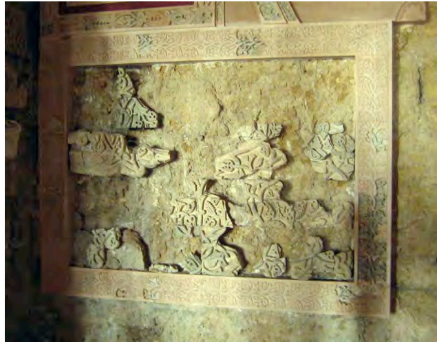
Intervenciones alternativas ensayadas en la historia de recomposición del ataurique en el Salón Rico
