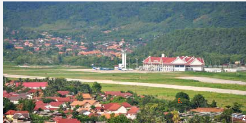
1. Extrait du SCOT : étude d'implantation des infrastructures (2004) 2. Désaxement de l'aéroport et nouveau terminal (2015)
