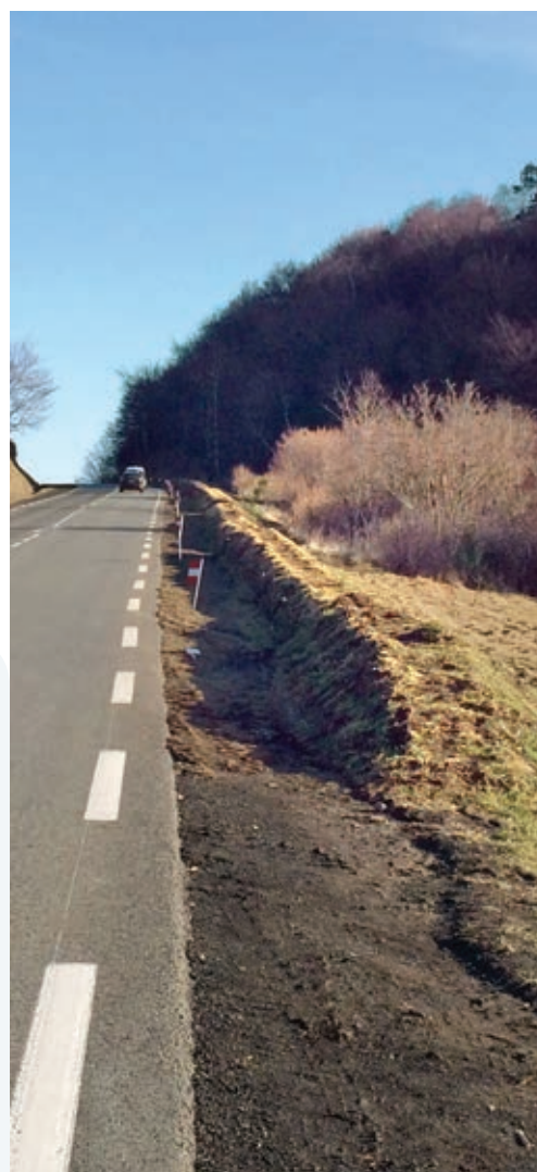
Suppression du stationnement inadapté au col des Goules par l'implantation d'un talus végétalisé © J. Way/Cd63
