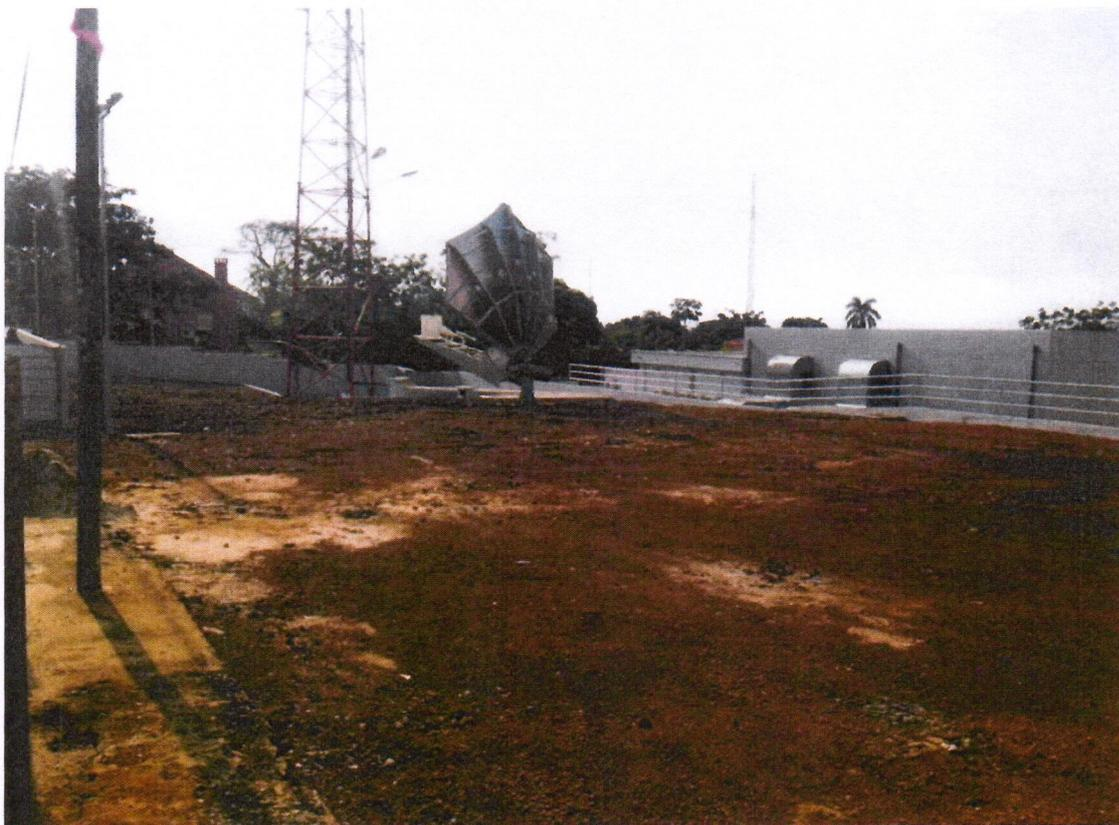
No terreno existia uma torre autosuportada com 30 metros de altura e uma antena Vsat, as quais tinham como objectivo de serem removidas.
