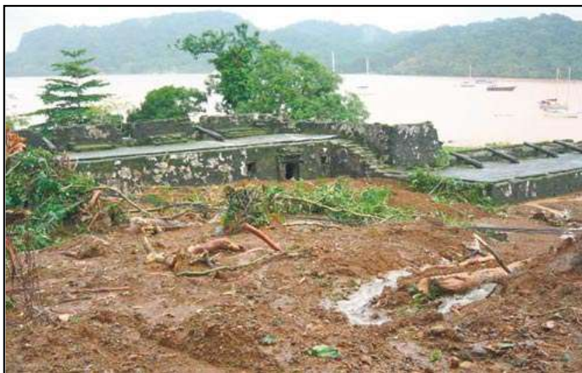
Foto 1. Fuerte de Santiago afectado por los deslizamientos, Portobelo Autor: Periódico El Panamá América, publicada el 23 sept. 2011
