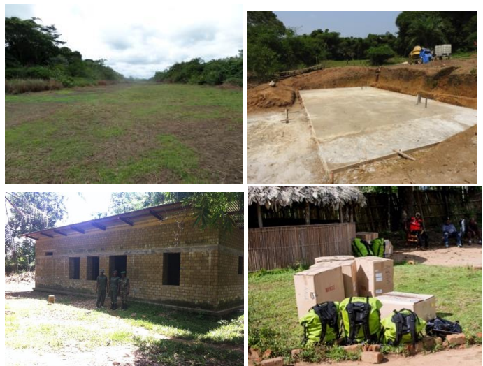
Fig. 5: Pistes d'atterrissage réhabilitée, construction des chalets
