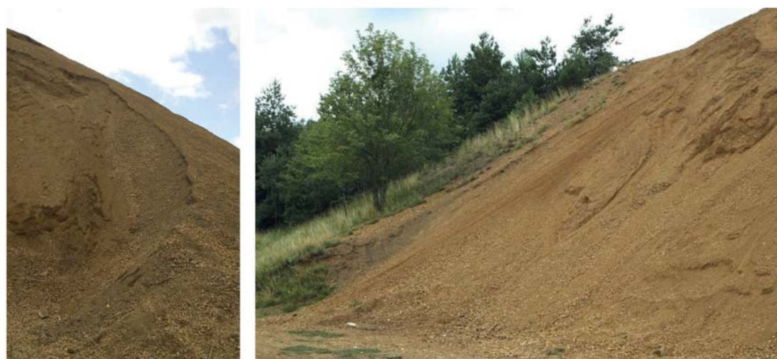
Ryc. 20, Ryc. 21 Uszkodzenia hałdy w wyniku wybierania materiału
