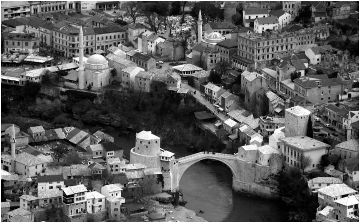
Vue aérienne du vieux pont (2005)
