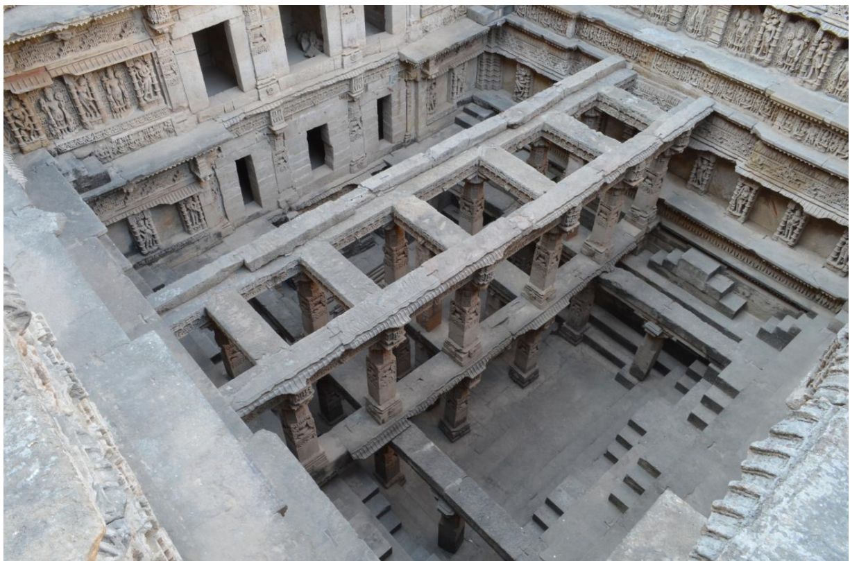
Structure de contreventement dans la citerne
