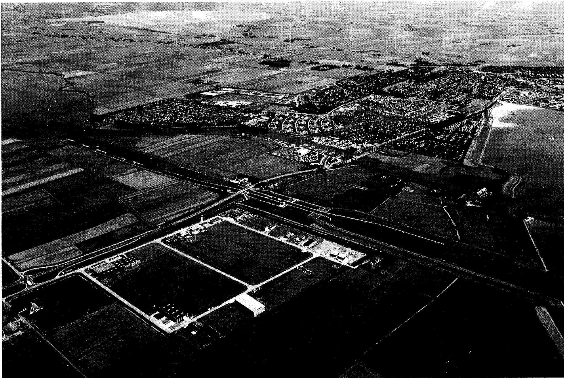
Ir. D.F. Woudagemaal (Station de pompage à la vapeur de D.F. Wouda) / Ir. D.F. Woudagemaal (D.F. Wouda Steam Pumping Station) : Vue aérienne / Aerial view
