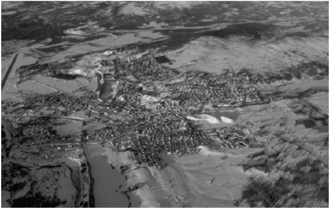
Vue aérienne de la ville minière de Røros et ses alentours
