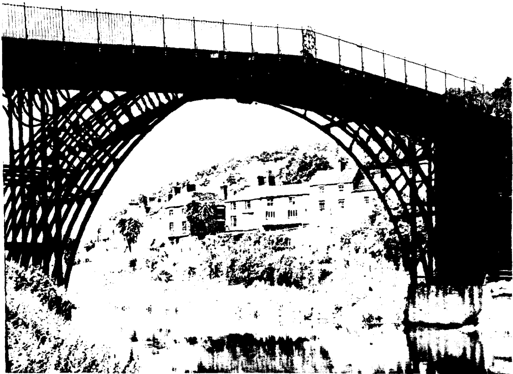
IRONBRIDGE. Le pont de Coalbrookdale.
