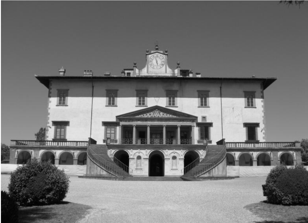
Villa de Poggio a Caiano, façade principale
