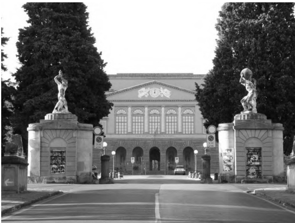
Villa du Poggio Imperiale, façade principale
