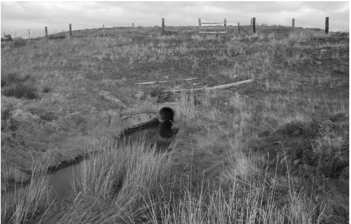
Aboiteau du système de drainage
