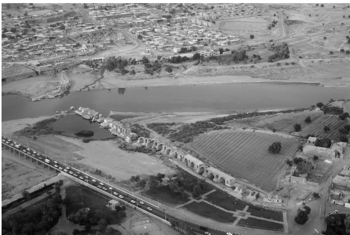
Pont-barrage Polband-e Shâdorvân
