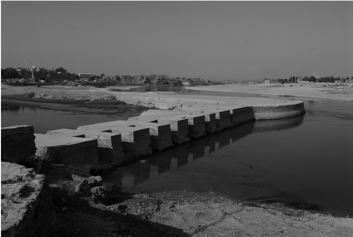
Barrage Band-e Mizân
