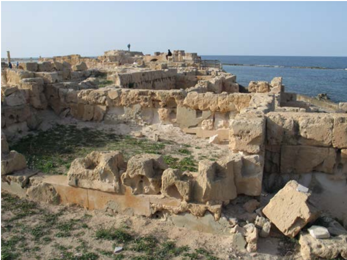
Figure 5 Sabratha Dégradation des grès de construction
