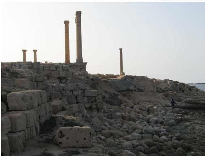
Figure 3 le temple d'Isis, érosion des structures par la mer
