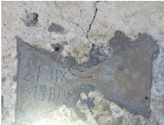
Figure 6: Système de surveillance des fissures dans la batterie Marie-Louise
