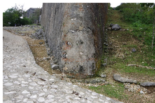
Figure 11: Contreforts de la batterie Coidavid
