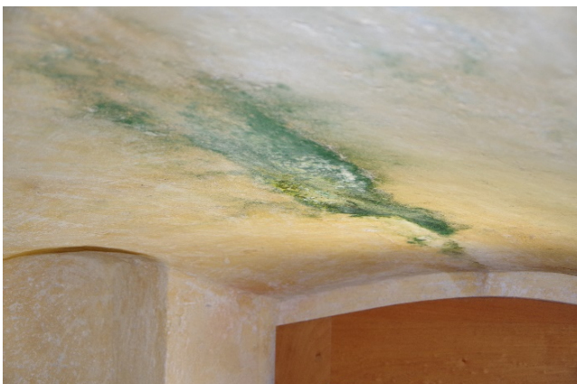
Figure 4: Batterie de la Reine - Problème d'humidité dans la zone d'exposition
