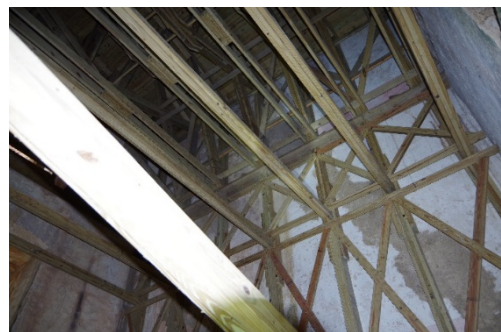
Figure 10: Batterie Coidavid - Échafaudage
