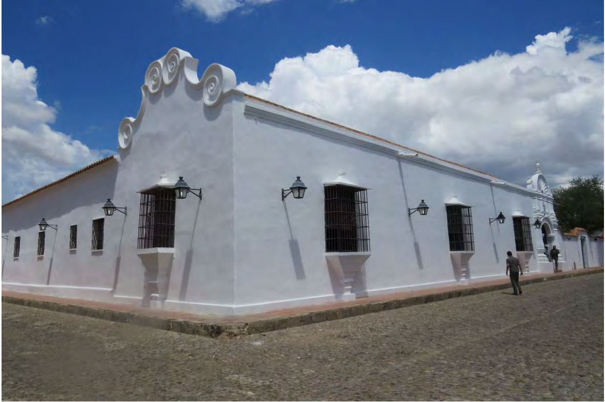
Photograph 06. Actual state of conservation of the Iron Windows House ( Casa de las Ventanas de Hierro )
