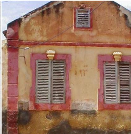
Chaîne d'angle et encadrement des fenêtres
