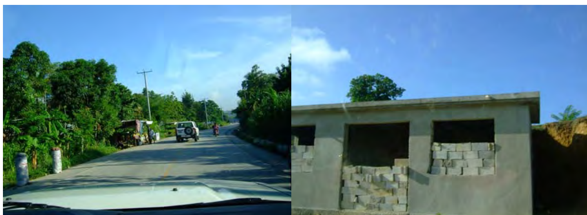
Sections rénovées de la Route Nationale 3
