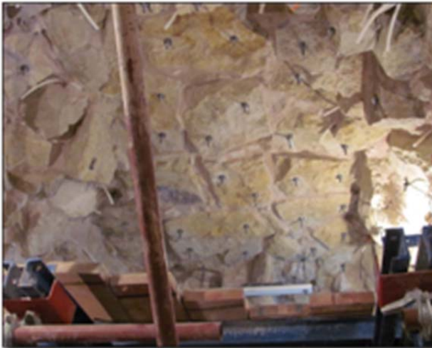
Fig. 1 – actual situation of tie-beams
