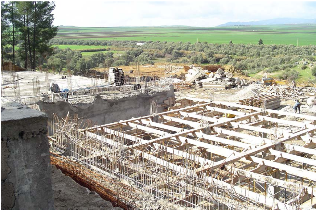
Travaux vus depuis l'entrée du site.
