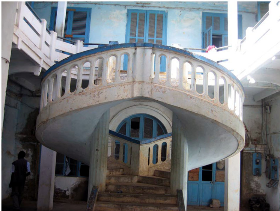
Cet édifice exceptionnel, récupérable à moindre frais était destiné à accueillir le bureau du Patrimoine. Il abritera un service administratif et sera requalifié.
