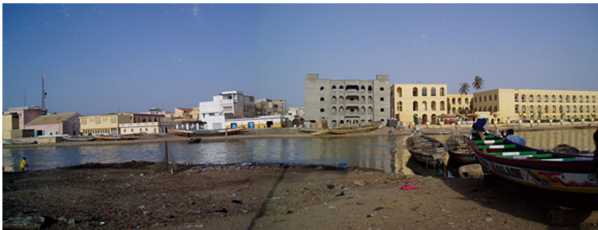
Depuis NDAR construction en cours à côté de l'hôpital (beaucoup trop imposante, un étage de trop)
