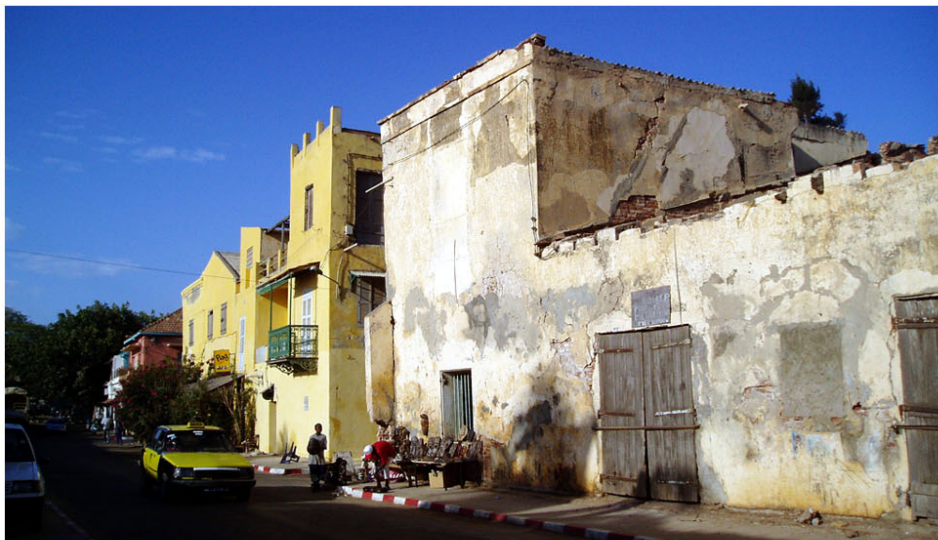
Sur le quai Est du quartier central un ancien entrepôt restant à restaurer
