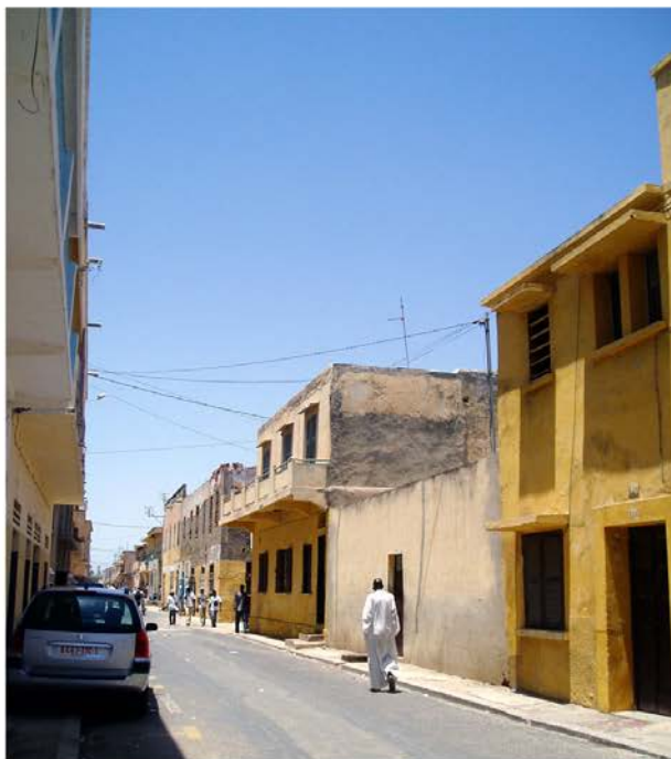
Les balcons de béton et les surélévations difficiles à gérer
