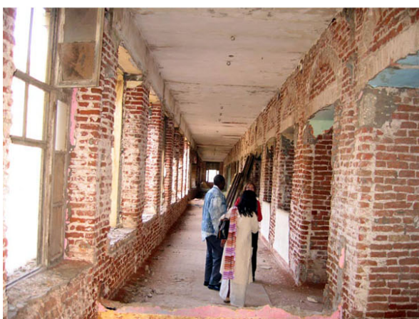
Le “Rognat Sud”, vaste bâtiment très intéressant prêt à être restauré. Reprise nécessaire de la large fissure verticale imputable à l’adjonction en béton armé (galerie de circulation et circulations verticales) et à un problème de fondation et chutes non récupérées.
