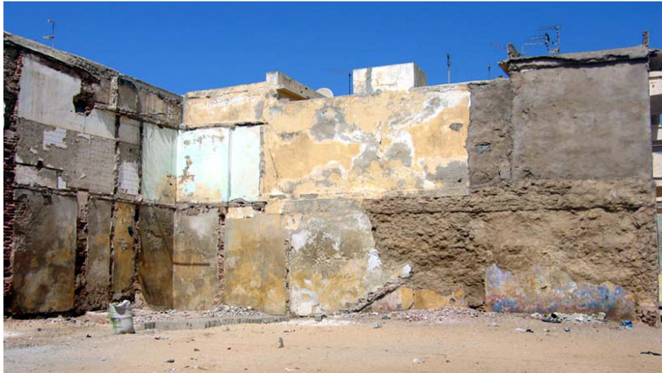
A l'angle de deux rues une démolition qui permettrait de créer un espace public dans le secteur Sud très dense
