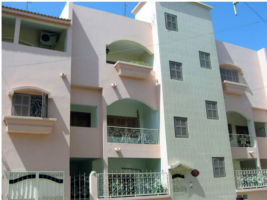
Une restauration ambitieuse et de qualité à côté d'une transformation radicale de très mauvais goût réalisée sans autorisation faisant l'objet d'une assignation
