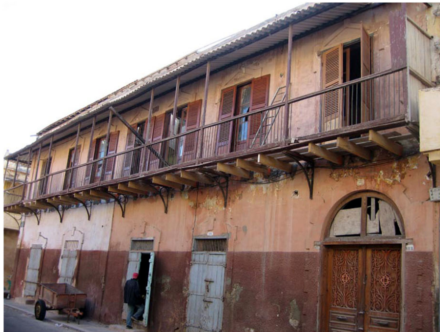
Balcon Saint Louisien en cours de restauration (étayé?). Travaux à suivre de près.
