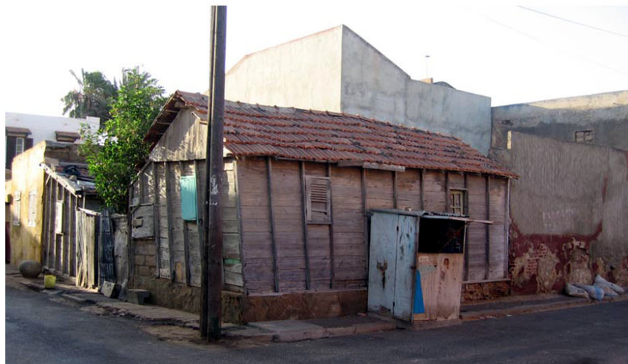
Une des rares constructions de bois encore en place et qui sera préservée.
