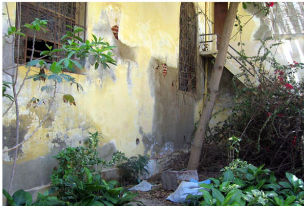
Fissures, décollement d'enduits dû aux extrêmes remontées d'eau (eaux de pluie et ruissellements mal gérés; végétation au pied des murs extérieurs)
