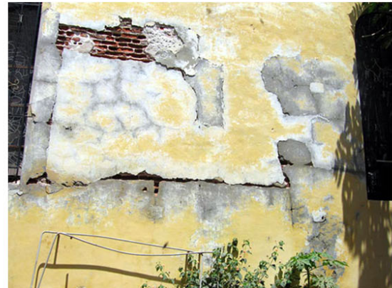
Fissures, décollement d'enduits dû aux extrêmes remontées d'eau (eaux de pluie et ruissellements mal gérés; végétation au pied des murs extérieurs)
